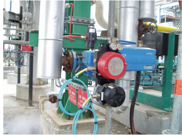
Аварийный отсечной клапан с системой тестирования при неполном ходе ValveGuard обеспечит безопасность труда на производстве
