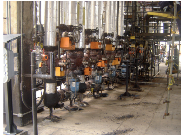
Клапаны Finetrol производства компании Metso на линии контроля расхода на нагревателе на одном из предприятий-заказчиков
