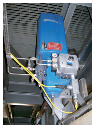
Привод серии В производства компании Metso, управляющий работой задвижки нагревателя на одном из предприятий-заказчиков
