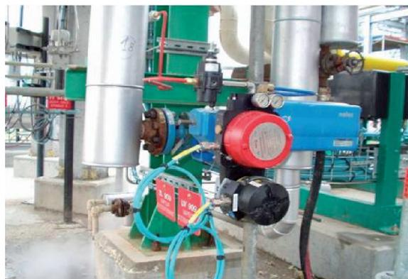
Аварийный отсечной клапан с системой тестирования при неполном ходе ValveGuard обеспечит безопасность труда на производстве
