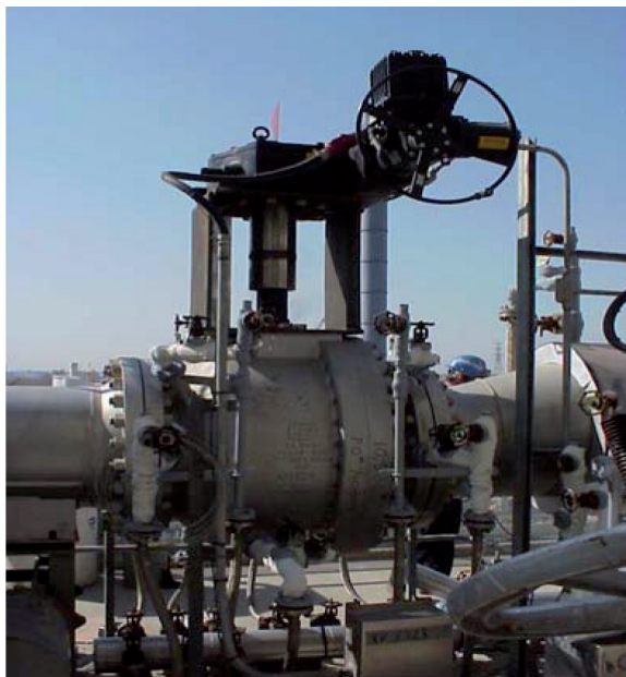
Рис. 3 Клапан серии MBV производства компании Metso с диаметром расходного отверстия 10»
