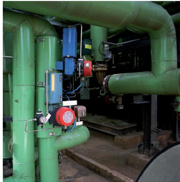
*Аварийный отсечной клапан с системой тестирования при неполном ходе ValveGuard обеспечит безопасность труда на производстве*
